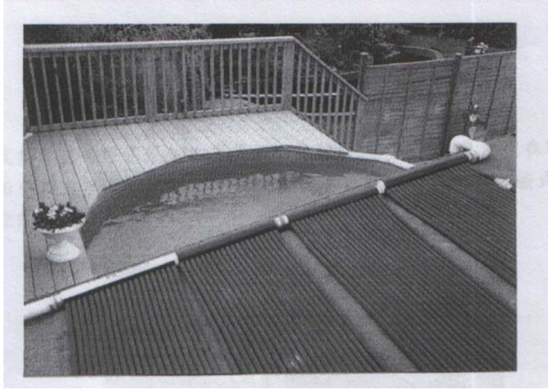
圖 5-2-13 應用於溫水游泳池之無面蓋 EPDM 式非金屬平板集熱器
