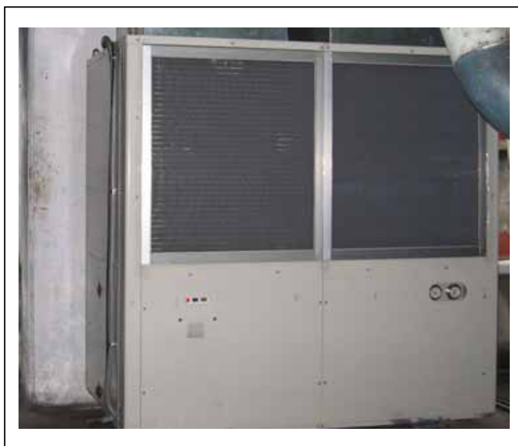
圖 4.6-3 成功案例運轉 9 年后里長青休閒度假山莊熱泵系統主機
