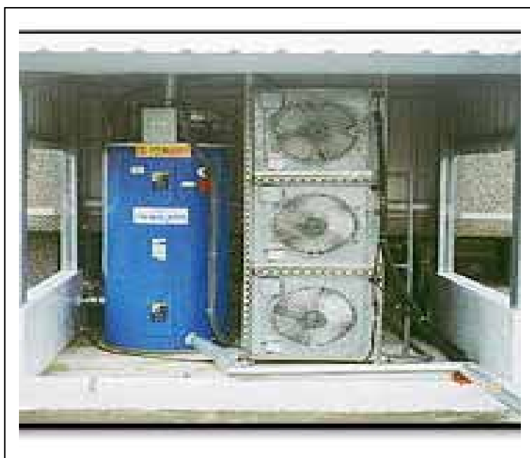
圖 4.6-2 成功案例運轉 9 年后里長青休閒度假山莊熱泵系統主機
