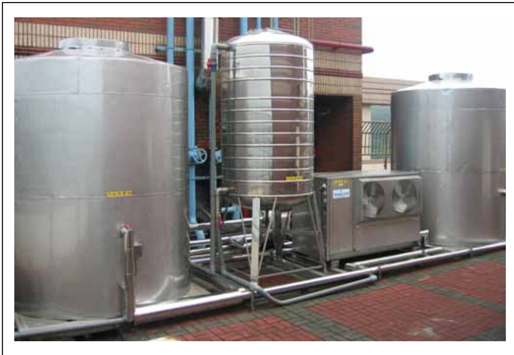
圖 4.8-3 基督教雙連教會熱泵系統實景
