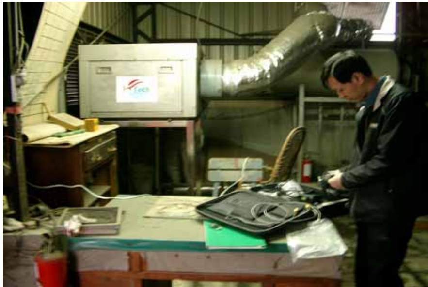
相片 5-6 醫院熱泵熱水系統效率測試
