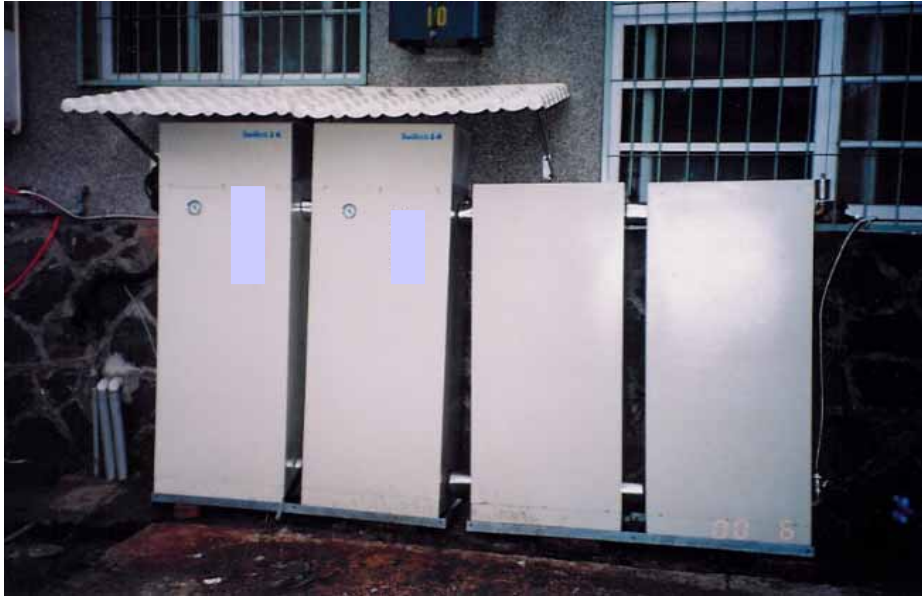
圖 4.9-1 可擴充式家用熱泵熱水器 NC120(兩台 120L 主機加兩台 120L 儲水槽)
