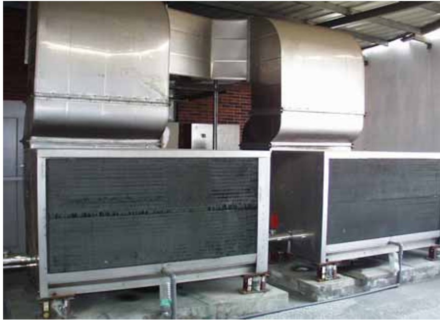
相片 5-3 學校宿舍空氣對水型熱泵熱水系統
