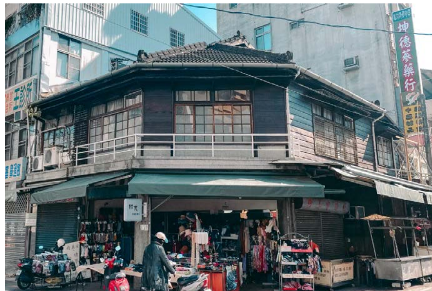
老屋卸妝(立面改善) 保存木構建築/採用LED燈具
